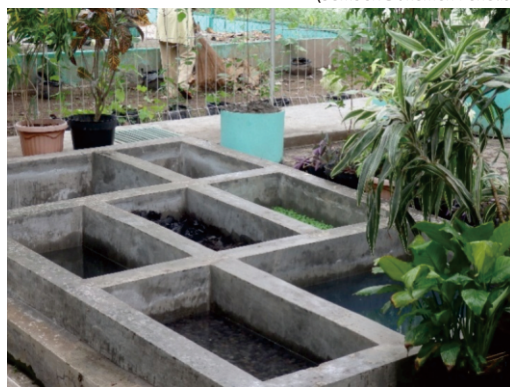
Gambar 7.13 Bak penampungan air limbah siap digunakan (Sumber: Dokumen Penulis)
