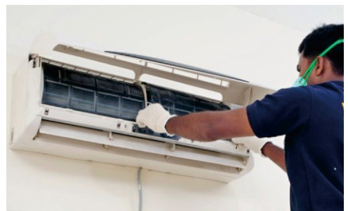
Gambar 1.11 Kerjasama dengan Maintenance and Repair Sumber: www.google.com
